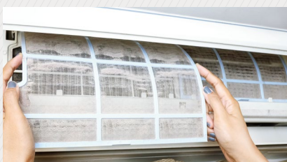
• 室内机换热器脏堵
