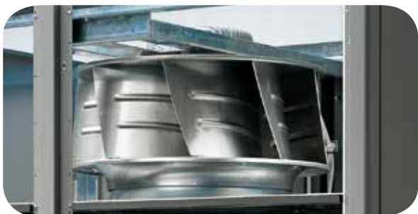
1 配有后倾叶片EC风机的下送风机组
